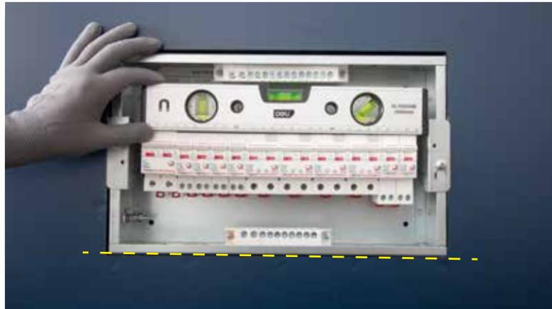
② 导轨调节到水平，螺丝刀拧紧
