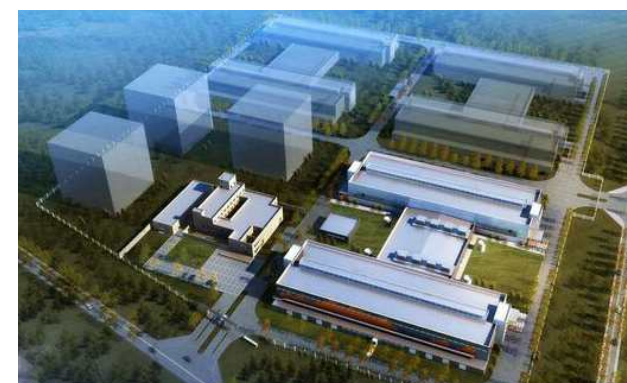
阿里数据港张北数据中心
