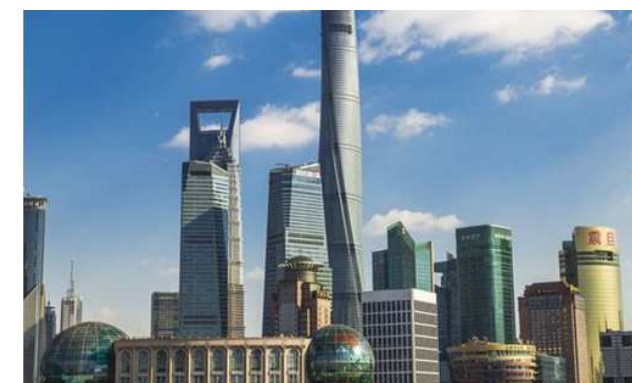
浦东云端数据中心
