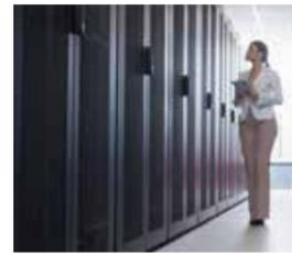
微模块数据中心采用一体化集成解决方案,集成了机柜系统、供配电系统、制冷系统、监控系统和综合布线系统,达到快速交付、按需部署的需求。
